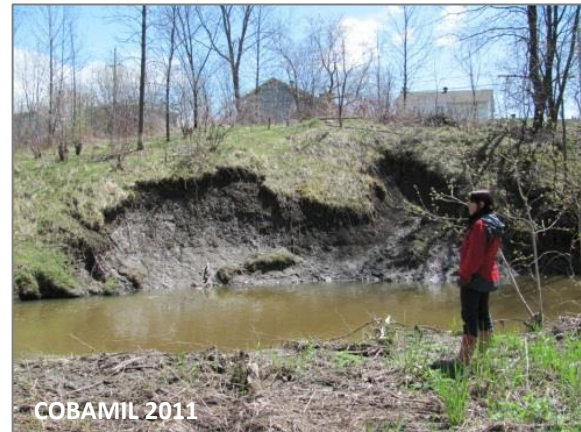
FIGURE 3 : DÉCROCHEMENT DE BERGE SUR LA RIVE DE LA RIVIÈRE AUX CHIENS
